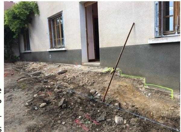
En ce mois de septembre, le maçon est en cours de réalisation d'une rampe d'accessibilité aux personnes à mobilité réduite. Une place de parking PMR est également en cours de réalisation dans la cour.
